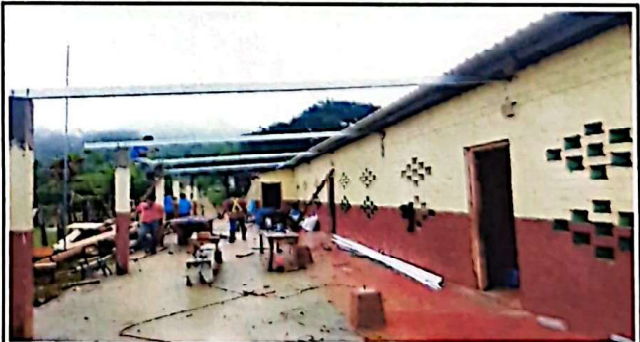
Foto 6: SUSTITUCION DE VIGAS EN EL CORREDOR
