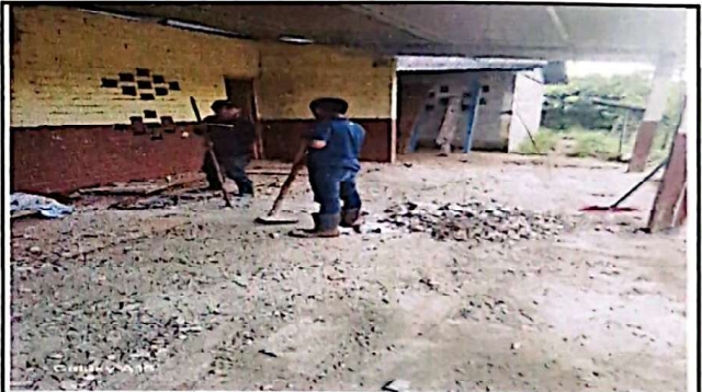
Foto 4: SUSTITUCION DE PISO
