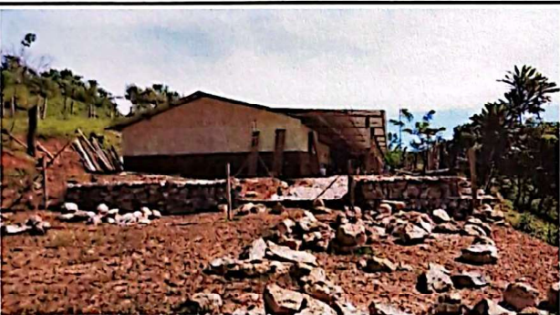
Foto 3: SUSTICION DE PUERTA DE ENTRADA
