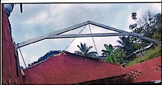
Foto 2: SUSTITUCION DE COSTANERAS PARA LAS AULAS
